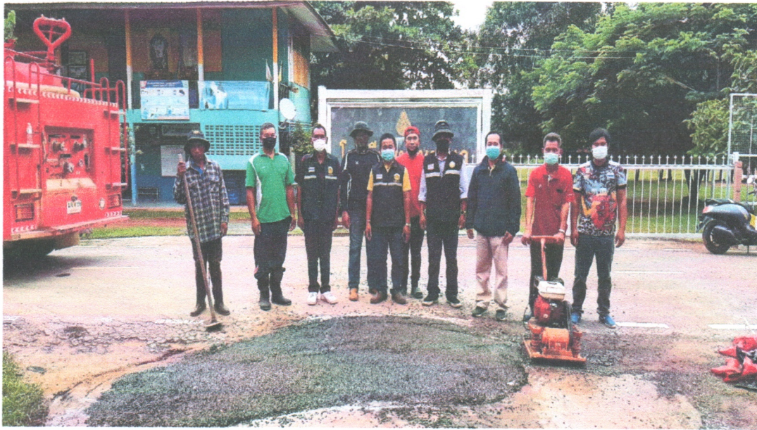
ภาพการดำเนินการซ่อมแซม ถนนเส้น ภายในบ้านนาแก หมู่ที่ 2 – บ้านนาอุดม หมู่ที่ 1 ตำบลโนนสมบูรณ์ อำเภอดงหลวง จังหวัดอุบลราชธานี วันที่ 25 พฤษภาคม 2565
